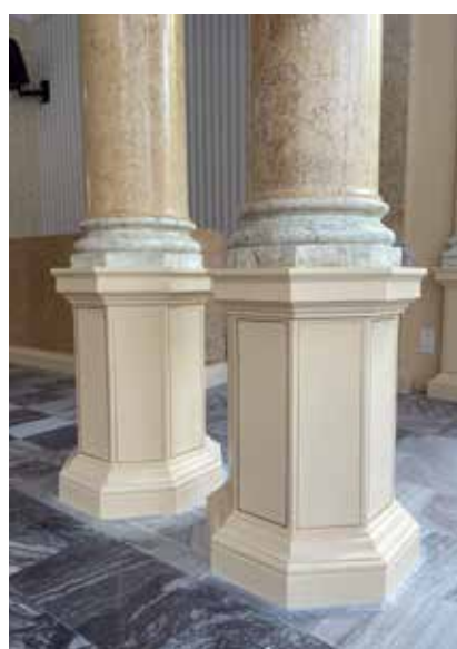
Fot. 8. Bazy i piedestały kolumn po rekonstrukcji; źródło: fot. autorki
