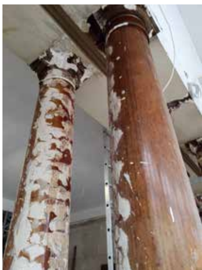
Fot. 5. Trzony kolumn po usunięciu wypełnienia z cegieł; źródło: fot. autorki
