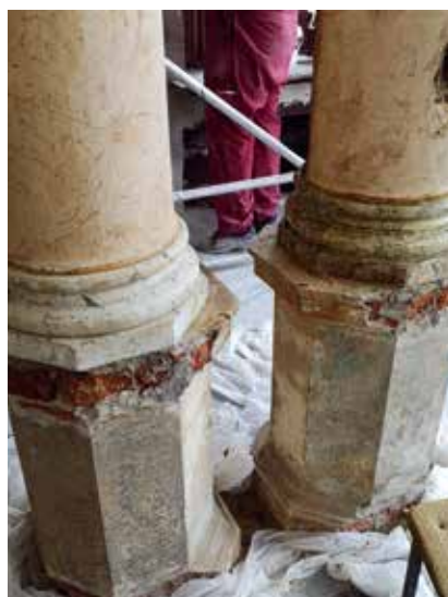
Fot. 6. Bazy i piedestały kolumn po usunięciu wypełnienia z cegieł; źródło: fot. autorki
