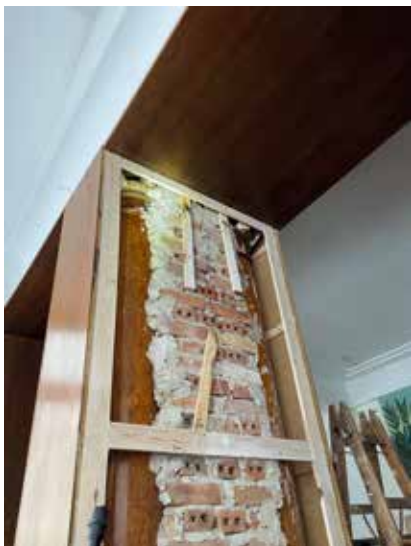
Fot. 3. Kolumny – stan w trakcie demontażu płyt meblowych; źródło: fot. autorki
