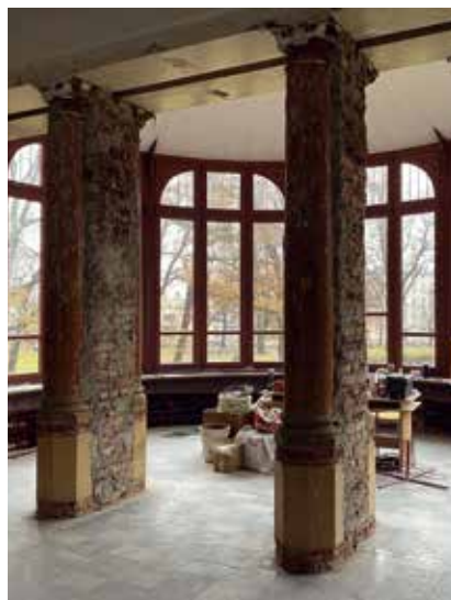
Fot. 4. Kolumny – stan po demontażu płyt meblowych; źródło: fot. autorki
