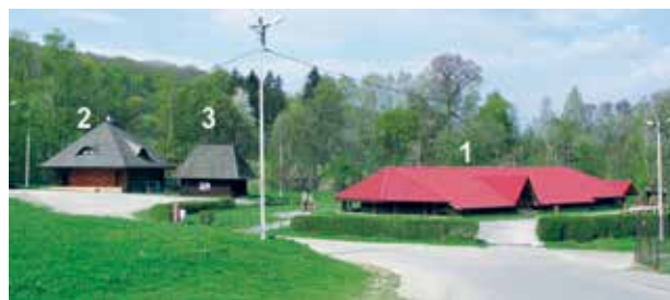
Il. 12. Zdjęcie stanu istniejącego po 12 latach. a. Sytuacja (1. przewizorycznie przykryta krypta, 2. zespół sanitarny, 3. spichlerz z Soboniowic, 4. spichlerz z Trzyciąża, 5. Plebania) b. widok od ulicy Cisowej [6]
