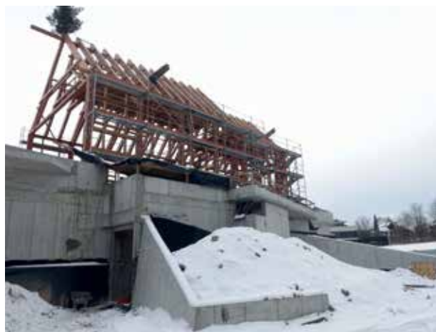
Il. 20. Konstrukcja drewniana w budowie, zbliżenie, stan w styczniu 2017. Fot. aut.
