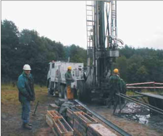
Fig. 3. Wiertnia DELTA podczas pracy na szczycie Góry Dylewskiej
