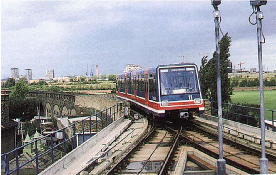
Rys. 4. Lekki pojazd szynowy systemu Dockland – przejazd przez rozjazd
