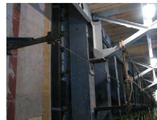
Rys. 8. Widok drutu pomiarowego do oceny rozszerzalności baterii koksowniczej
