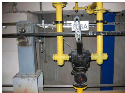
Rys. 6. Widok podłączonych do docelowego kolektora gazu kurka rewersyjnego wraz z mechanizmem (kluczem) jego przestawiania.
