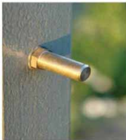
Fot. 2. Nowy znak regulacji osi toru zgodny z Ig-6
