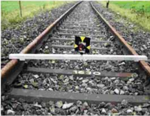
Fot. 3. Łata wyposażona w reflektor pryzmatyczny umieszczony w osi toru
