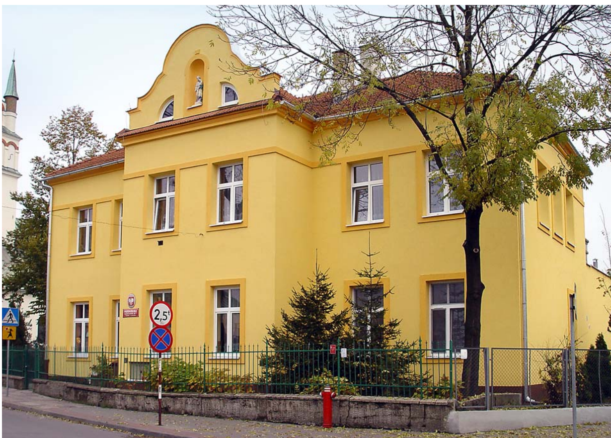
Ryc. 21. Dawna ochronka miejska w Skawinie, stan istniejący, fot. M. Krupa, 2014
