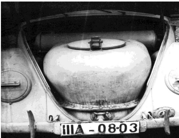
Rys. 15. Gazogenerator
