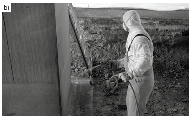
Rys. 10. Rozkład zawartości jonów chlorkowych w elemencie żelbetowym (a), proces impregnacji (b)
