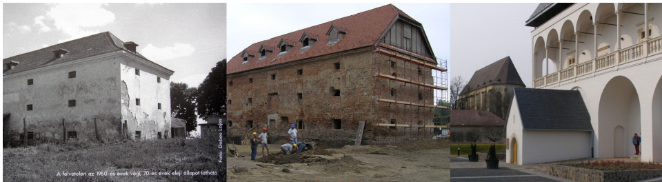
Fig.6 The granary/castle of Nyírbátor around 1970 (photo: Lajos Dobos – in: Örökség , 2007, no. 2, p. 4), in the years 2005 and 2007; Photo: Ádám Arnóth
