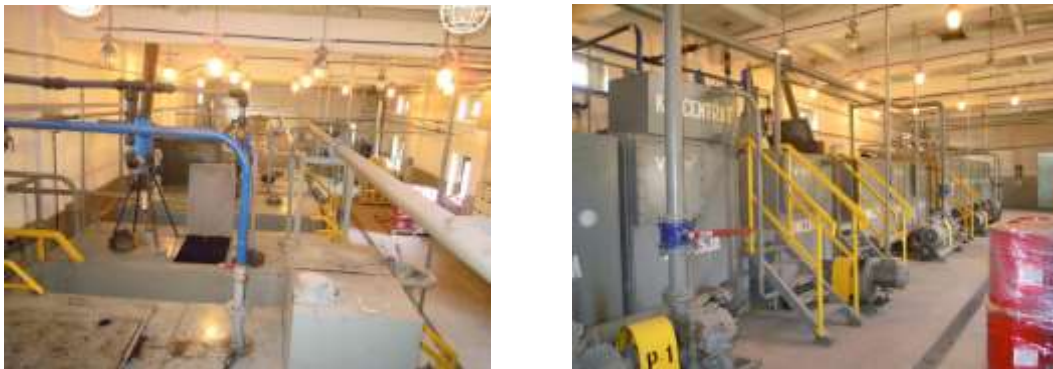
Rys. 12.2 Kopalniana centralna emulgatornia na powierzchni
