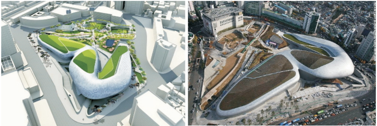
Ryc. 5. Zaha Hadid Architects, Dongdaemun Design Plaza, Seul, Korea Południowa, 2007–2014 a) projekt koncepcyjny – wizualizacja, b) widok zrealizowanego obiektu; źródło: dzięki uprzejmości Zaha Hadid Architects /source: courtesy Zaha Hadid Architects
