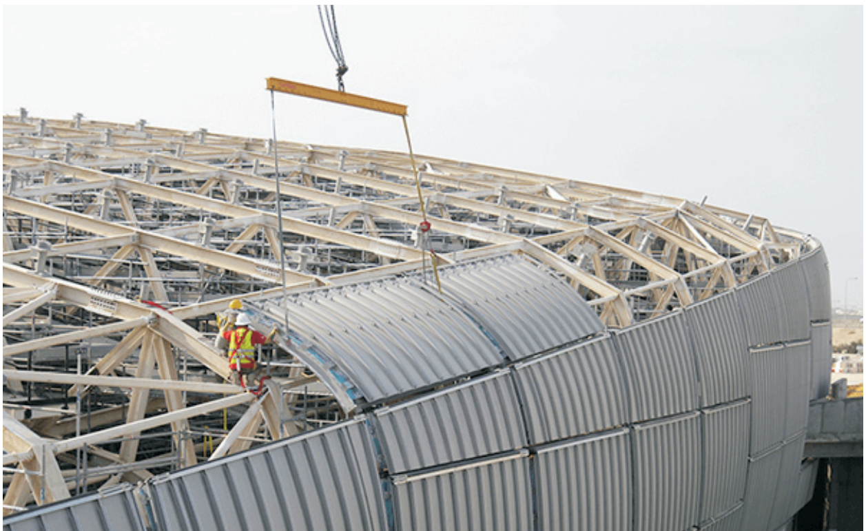
Ryc. 18 a i b. Snøhetta, King Abdulaziz Centre for World Culture, montaż na placu budowy; źródło: dzięki uprzejmości Snøhetta/source: courtesy Snøhetta
