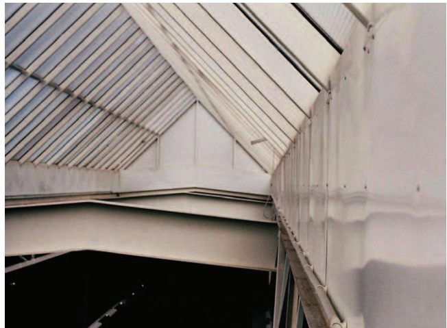
Rys. 3. Widok świetlika od wnętrza hali
