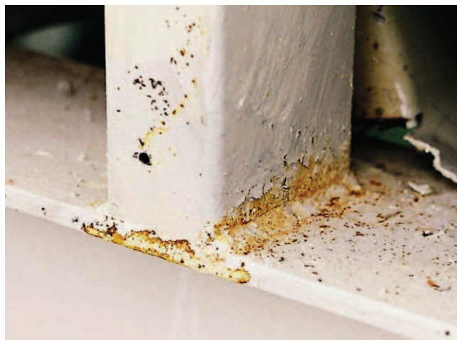
Rys. 6. Połączenie słupka ramy z płatiwą
