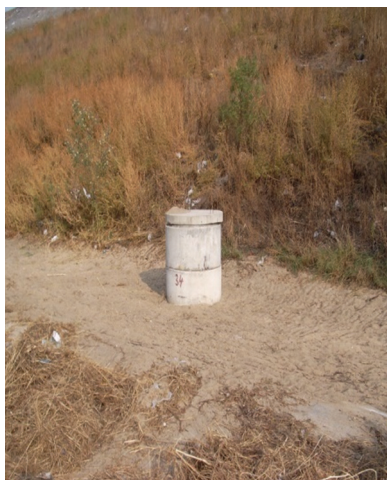
Rys. 2a. Studzienka z odciekami
