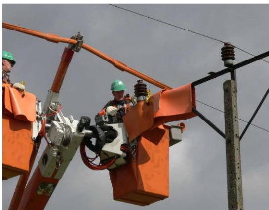
Rys. 4. PPN metoda C3M, wymiana izolatora na słupie przelotowym linii 15 kV
