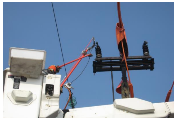
Rys. 3. PPN metodą w odległości, demontaż mostka odłącznika na linii 15 kV
