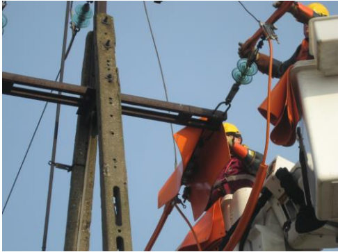
Rys. 2. PPN metodą w kontakcie, izolowanie strefy pracy na linii 15 kV
