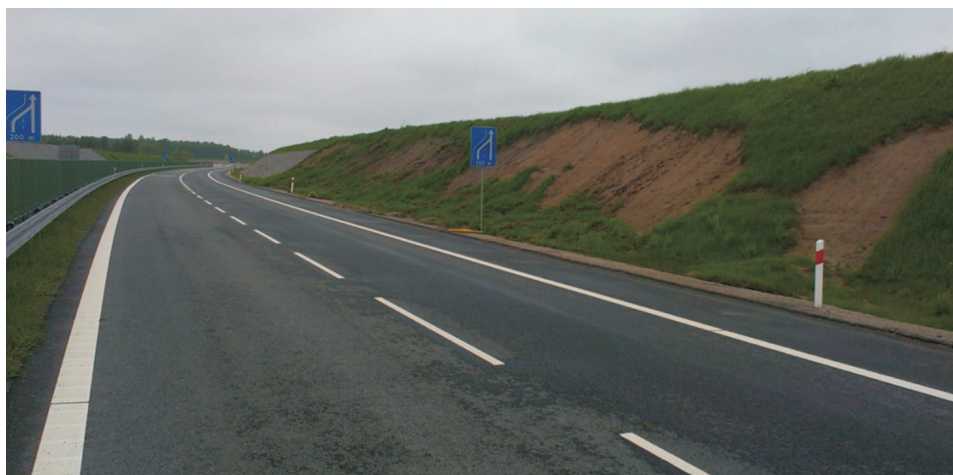
Rys. 4.2. Zniszczenie przeciwskaarp — spływ humusowania
