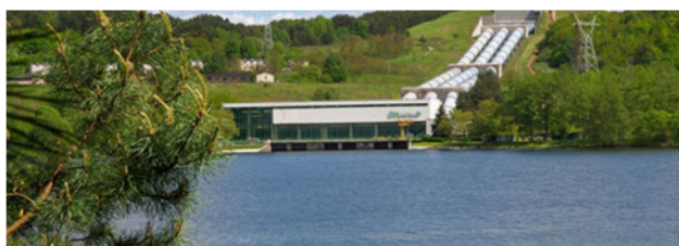
Rys. 6. Elektrownia wodna Żydowo. Źródło: [4] Fig. 6. Żydowo hydroelectric power plant. Source: [4]
