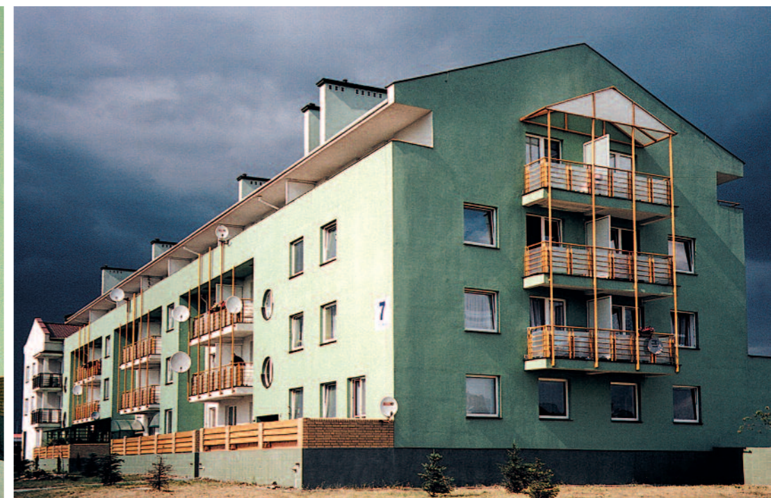
▲ Zespół mieszkaniowy – Tarnów ul. Rydza - Śmigłego 7 - I etap realizacji, 1997 - 2000. Residential complex – Tarnów, 7 Rydza-Śmigłego Street - 1st stage of implementation. Autorzy: / Authors: arch. arch. Małgorzata Buratyńska - Seruga, Jakub Seruga, Wacław Seruga, Kazimierz Hamada.
