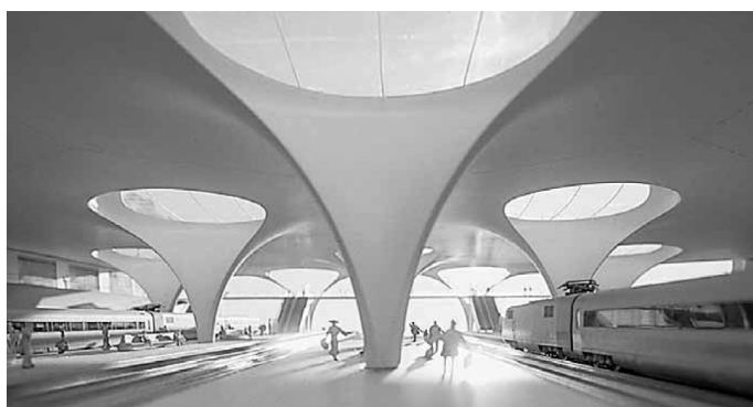
Rys. 5. Podziemne perony nowego dworca głównego w Stuttgartu Źródło: „Stuttgart 21” Talquerung mit Hauptbahnhof, Deutsche Bahn (DB), 2005
