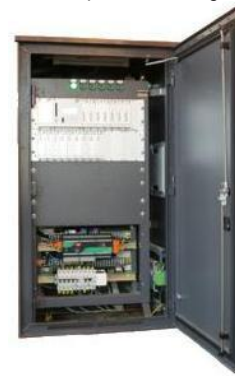
Rys. 5. Sterownik sygnalizacji świetlnej ASC-42. Źródło: Archiwum ARES Sp. z o.o.
