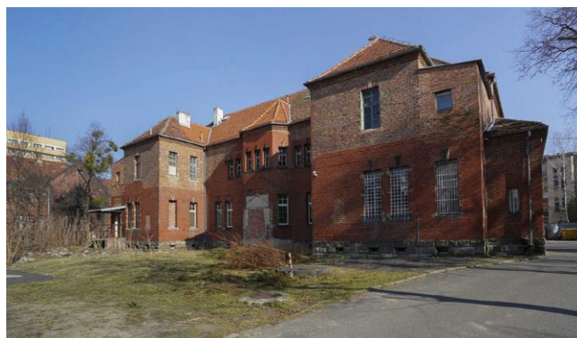
Rys. 6. Aktualny widok elewacji tylnej budynku – widoczna dokonana nadbudowa
