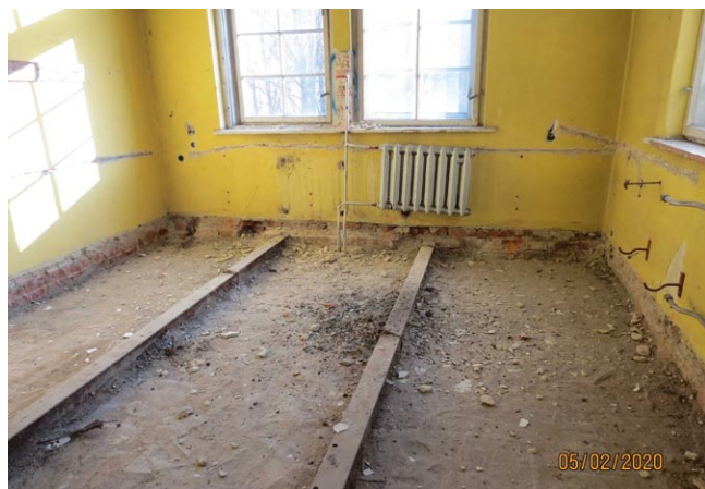
Rys. 13. Odkrywka stropu nad parterem
