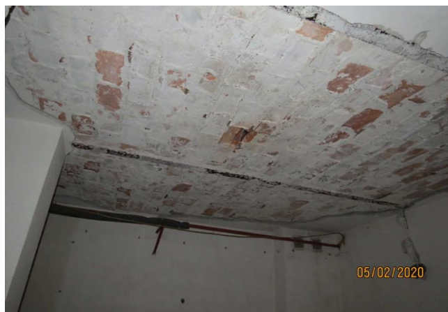
Rys. 11. Widok stropu nad piwnicą
