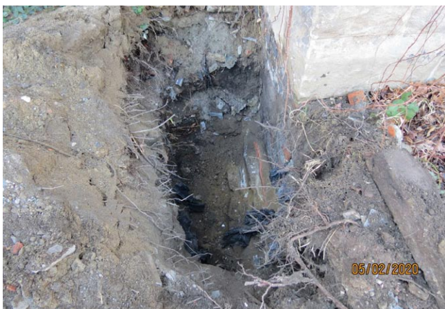
Rys. 9. Odkrywka fundamentu
