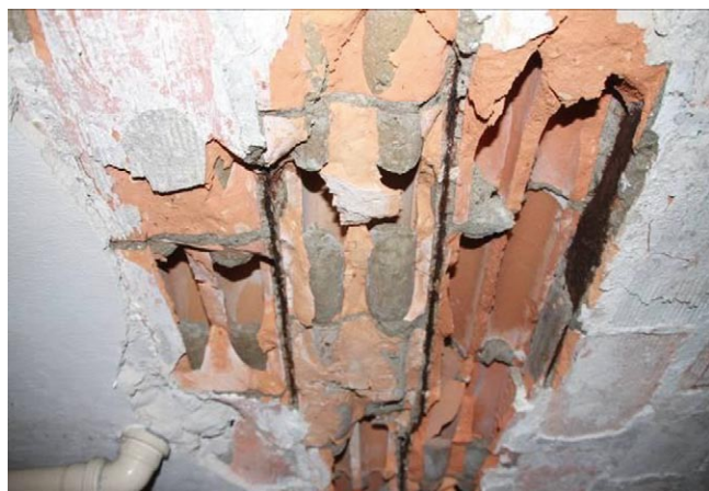
Rys. 14. Szczegół odkrywki w stropie Kleina
