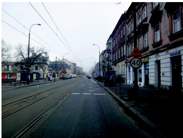
Fot. 7. Przykład zamontowanych słupków przed przystankiem tramwajowym w Krakowie
