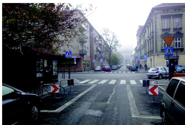
Fot. 6. Przykład zamontowania stojaków rowerowych przed skrzyżowaniem w Krakowie
