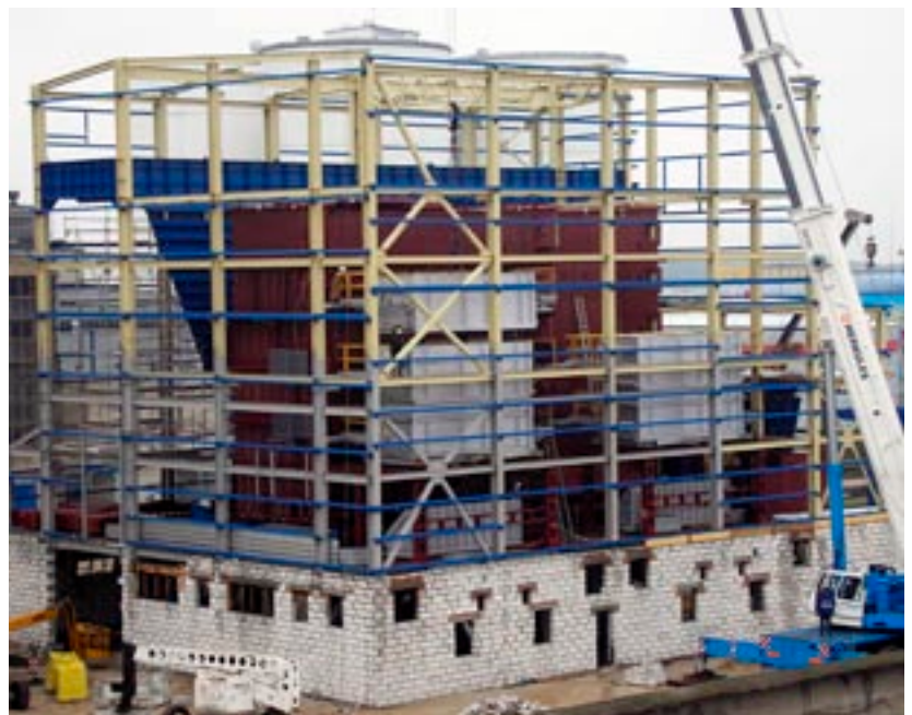
Plac budowy dwóch kotłów OR-50 w cukrowni w Krasnymstawie
