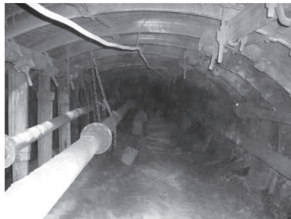
Rys. 5. Wypiętrzenie spągu za frontem ściany, przy zabudowanym pasie podporowym
