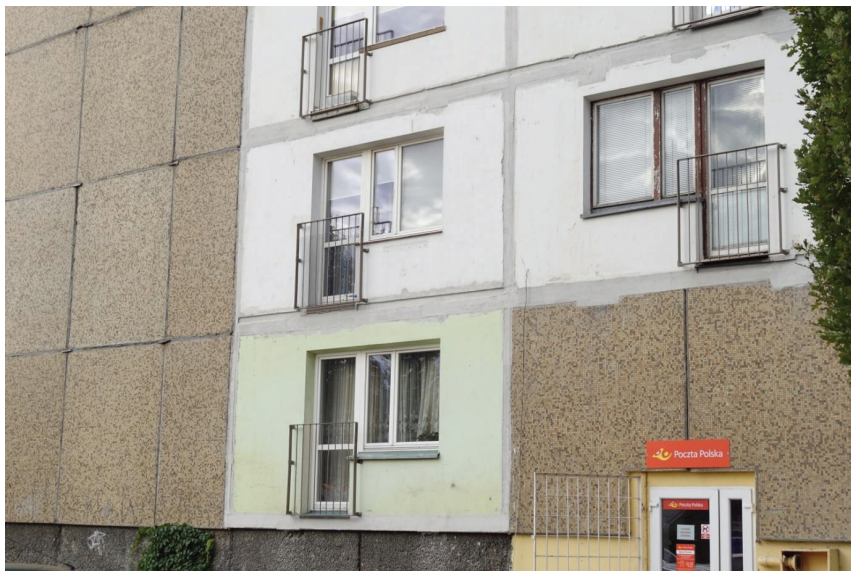
Rys. 8. Widok elewacji budynku wysokiego po rozebraniu loggii (Poznań 2018)
