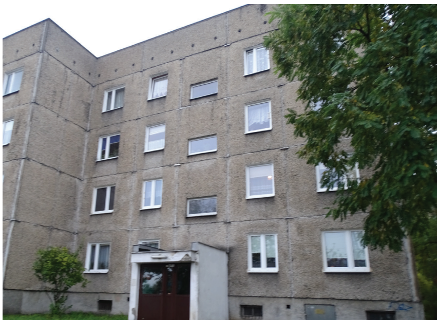
Rys. 2. Elewacja budynku bez docieplenia (Warszawa 2016)
