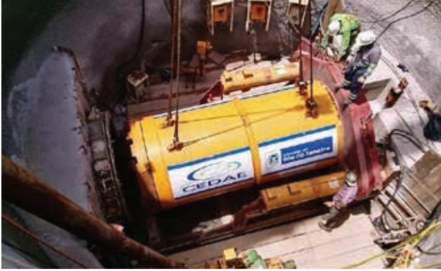
Ryc. 3. Opuszczenie głowicy typu TBM na dno wykopu [1]
