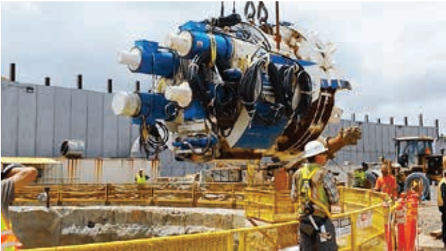
Ryc. 7. Wyciąganie głowicy z komory odbiorczej [1]
