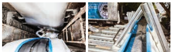
Ryc. 9. Instalacja powłoki w kanale [1]
