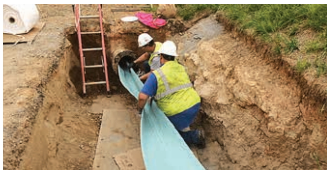
Ryc. 10. Instalacja powłoki Flow-Liner we wnętrzu przewodu [1]
