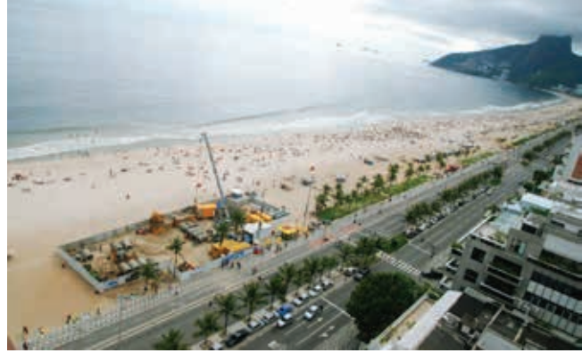
Ryc. 4. Widok z góry na plac budowy [1]
