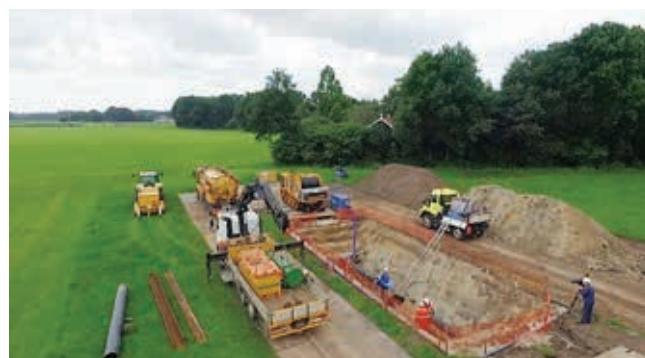
Ryc. 2. Instalacja powłoki w wykopie [1]
