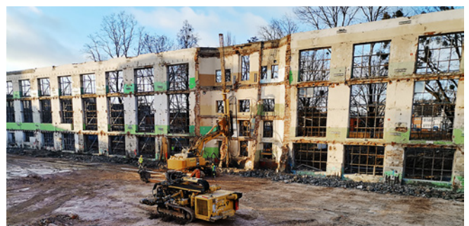
Podbijanie fundamentów Manufaktury Widzewskiej [3]
