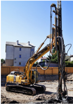
Wykonywanie poziomej przesłony przeciwfiltracyjnej [3]
