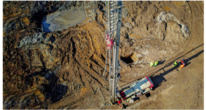
Wykonywanie pionowej przesłony doszczelniającej [3]
