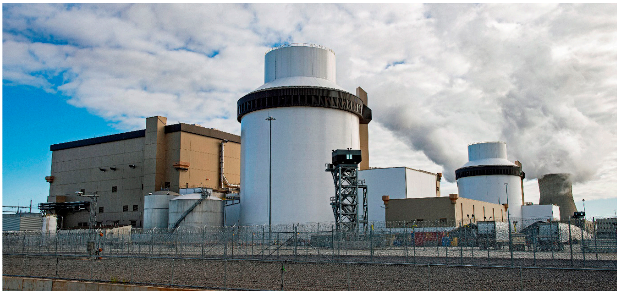
Fot. 2. Nowe bloki Elektrowni Jądrowej Vogtle. Na pierwszym planie blok 4, w tle blok 3. Fotografia z października 2023 r. (fot. Georgia Power Company)
