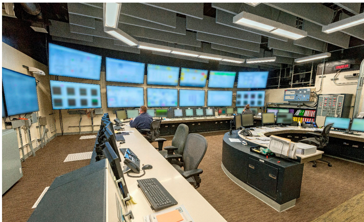
Fot. 4. Pomieszczenie głównej sterowni bloku Vogtle 4 – październik 2023 r. (fot. Georgia Power Company) Photo 4. Main control room of Vogtle 4 unit – October 2023 (photo Georgia Power Company)
