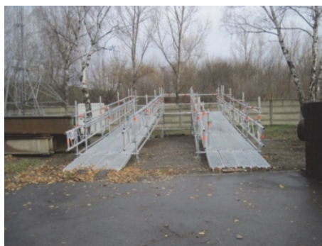
Rys. 3. Montaż elementów pochylni (fot. K. Kaperczak, 2015)
