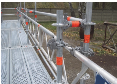
Rys. 4. Zamocowanie pojedynczej poręczy na biegu zmodyfikowanym oraz oznakowanie pochylni symbolami dedykowanymi osobom niepełnosprawnym po prawej stronie biegu (fot. K. Kaperczak, 2015)
