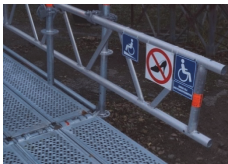
Rys. 4. Zamocowanie pojedynczej poręczy na biegu zmodyfikowanym oraz oznakowanie pochylni symbolami dedykowanymi osobom niepełnosprawnym po prawej stronie biegu (fot. K. Kaperczak, 2015)
