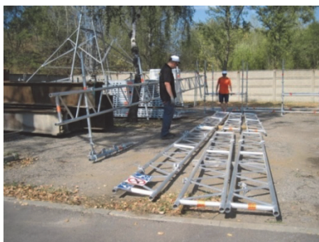
Rys. 3. Montaż elementów pochylni (fot. K. Kaperczak, 2015)
