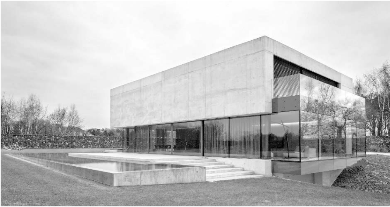
II. 3. db 2, dom prywatny, Bierkowice, 2015. Detal przekroju przez ścianę ogrodową (bez skali) oraz zdjęcie (fot. M. Teńczyńska-Korluk).
