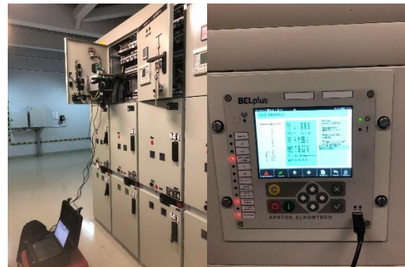
Rys. 13. Widok na urządzenie przygotowane do rejestracji i oceny stanu klatki silnika dużej mocy na stanowisku pracy w przemyśle (zdjęcie po lewej), testy zabezpieczenia BEL_plus (zdjęcie po prawej)
