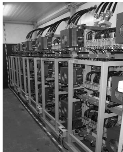
Rys. 9. Człony kondensatorowe układu TSC
