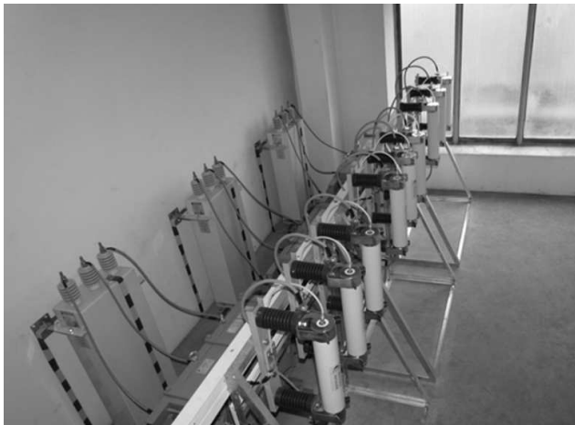
Rys. 7. Przykładowy układ filtrów pasywnych 6 kV
