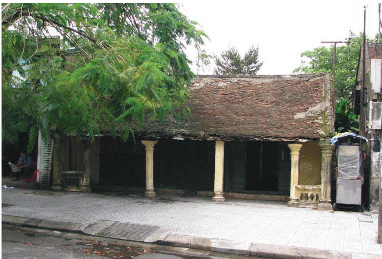
il. 10. Dawna zabudowa w cytadeli (Marek Barański) ill. 10. Historic housing in citadel (Marek Barański)
