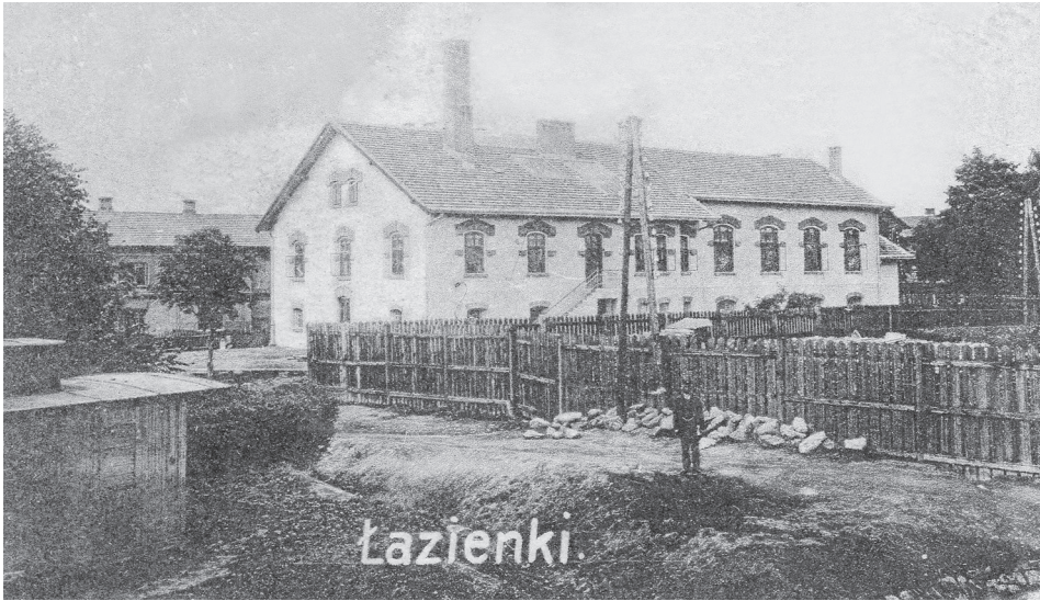
Fot. 41. Budynek łaźni w 1908 roku 87 Widok od strony torów.
