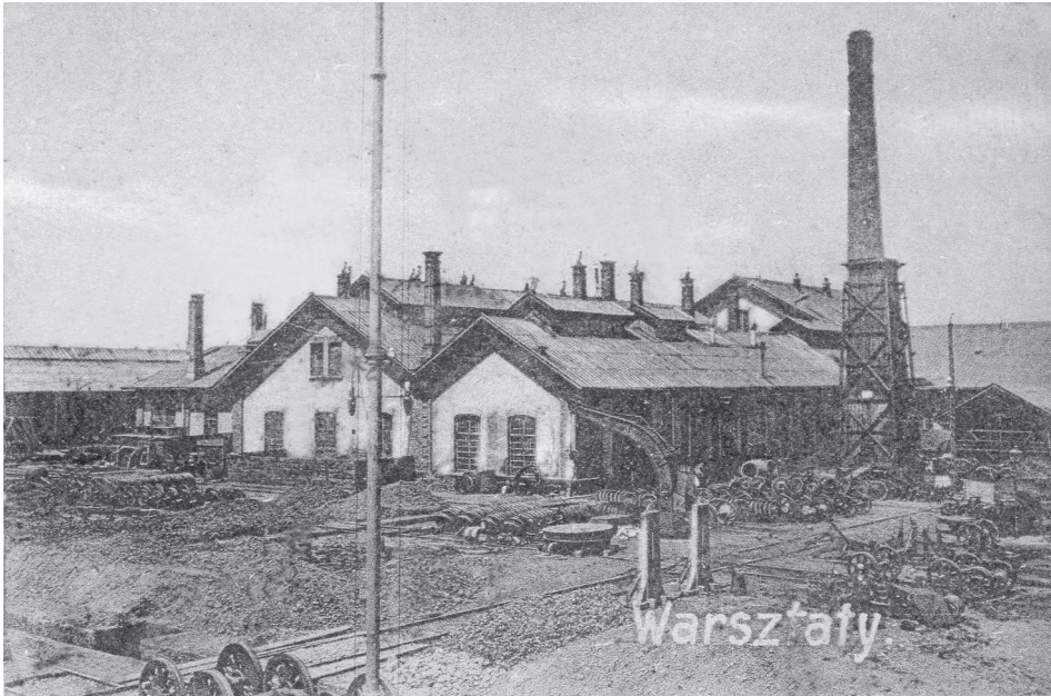
Fot. 47. Budynek kuźni i warsztatu ślusarskiego na terenie Warsztatów Głównych w 1908 roku 95
