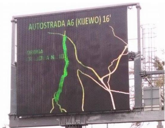
Rys. 4. Tablica zmiennej treści informująca o bieżącym natężeniu ruchu drogowego i przepustowości sieci dróg
