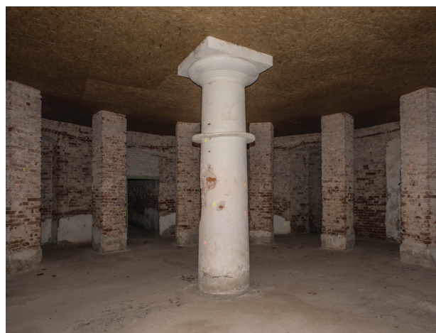
Il. 6. Pałac Seherr-Thossów w Szymanowie. Najniższa kondygnacja (piwniczna) centralnej sali rotundowej (fot. J.K. Kos, 2019)
