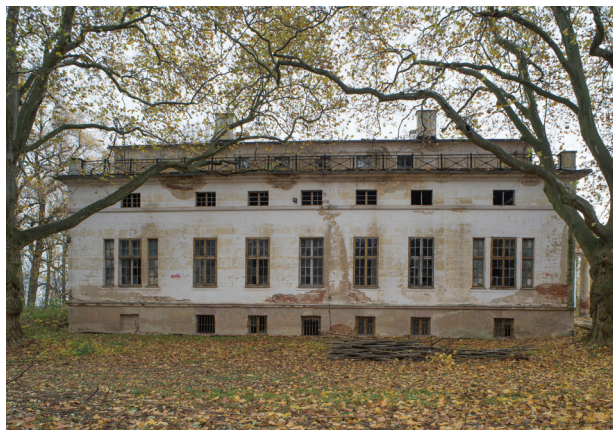
Il. 3. Pałac Seherr-Thossów w Szymanowie. Elewacja boczna pałacu (fot. J.K. Kos, 2019)
