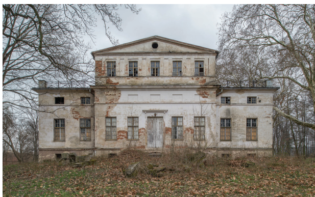
Il. 4. Pałac Seherr-Thossów w Szymanowie. Elewacja tylna pałacu (fot. J.K. Kos, 2019)
