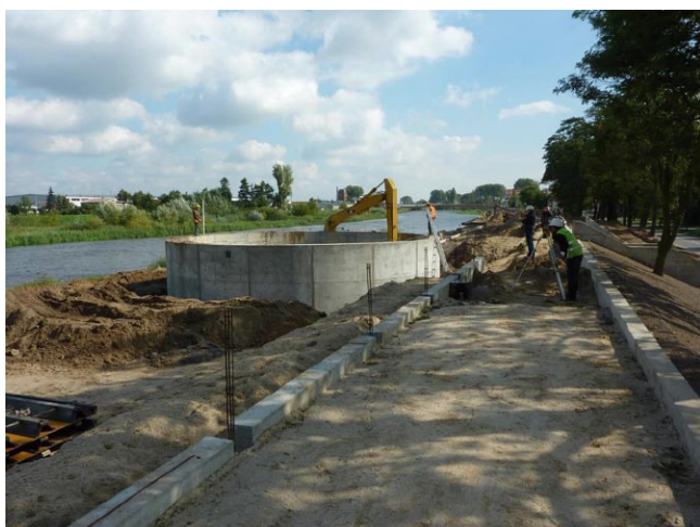
Rys. 4. Prace budowlane przy opuszczaniu studni w Koninie; początek pogrążania studni [1]
