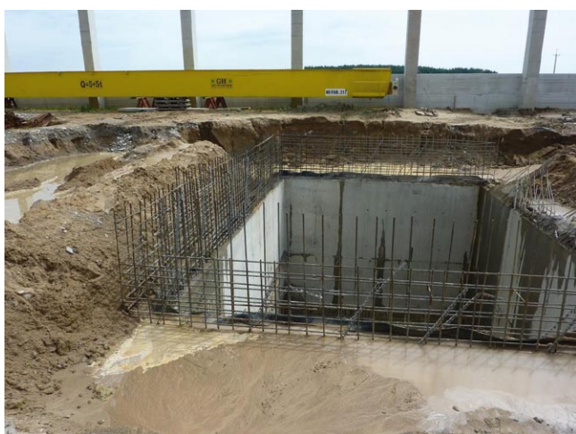
Rys. 3. Prace budowlane przy opuszczaniu studni „A” w Sobocie, k. Poznań; opuszczany drugi segment studni [1]
