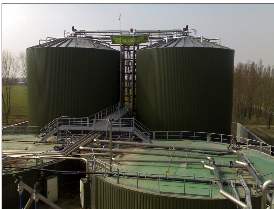
Fot. 8. Zbiornik stalowy (Fot. autor 2015) Fot. 8. Steel tank
