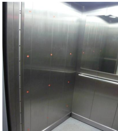
Rys.4. Ściana kabiny dźwigu z przygotowanymi punktami pomiarowymi
