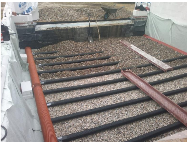
Rys. 3. Montaż GPWC grzebiennego ( www.grzebieniowygwc.pl )
