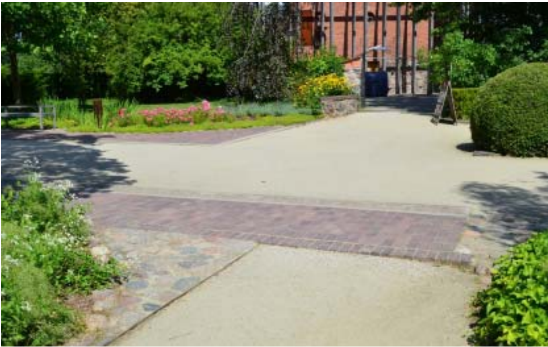
Il. 4. Połączenie nawierzchni zabytkowych z nowymi alejkami w systemie HanseGrand. Fot. A. Tarnawska.
