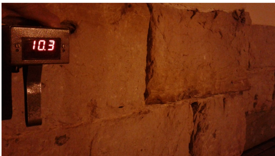
Rys. 6. Cokół kamienny, fot. autor, grudzień 2016
