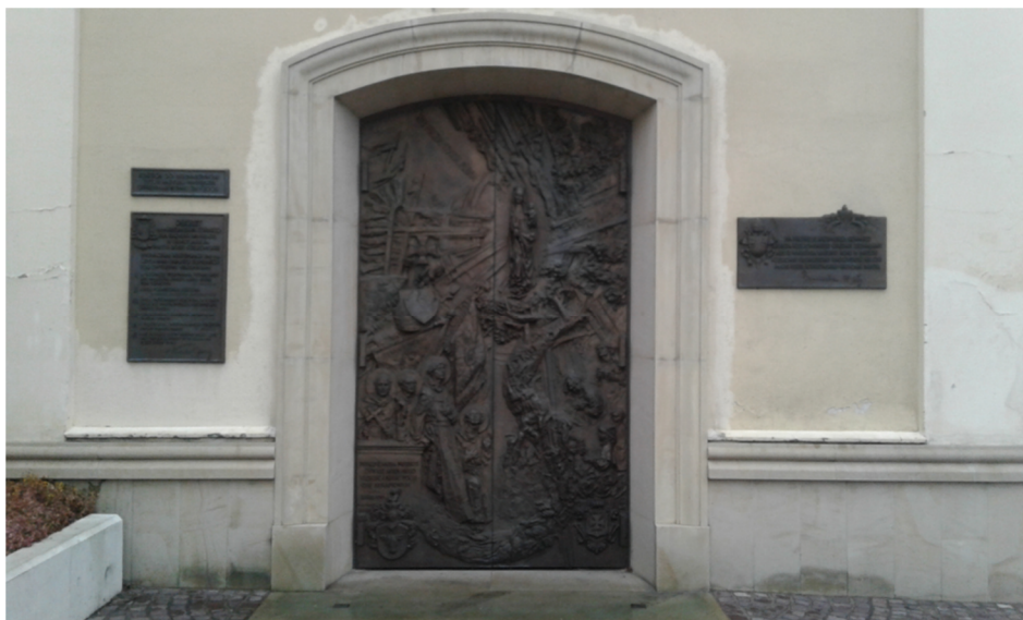
Rys. 1. Zachodnia elewacja wieży, fot. autor, październik 2016
