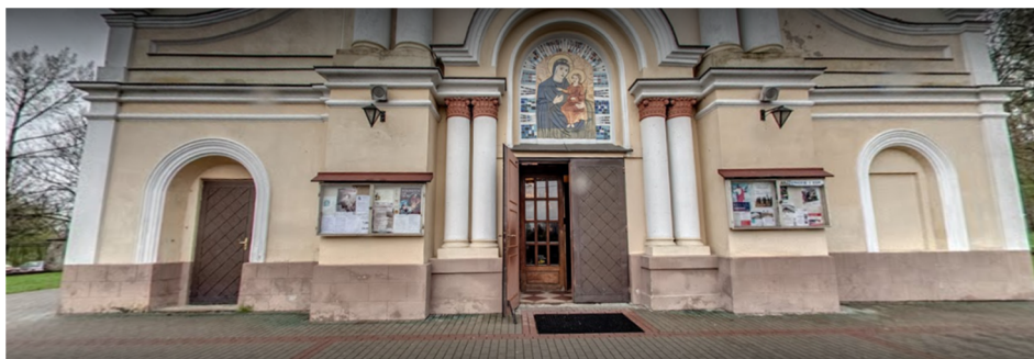
Rys. 5. Elewacja frontowa, fot. Google Mapy, kwiecień 2016
