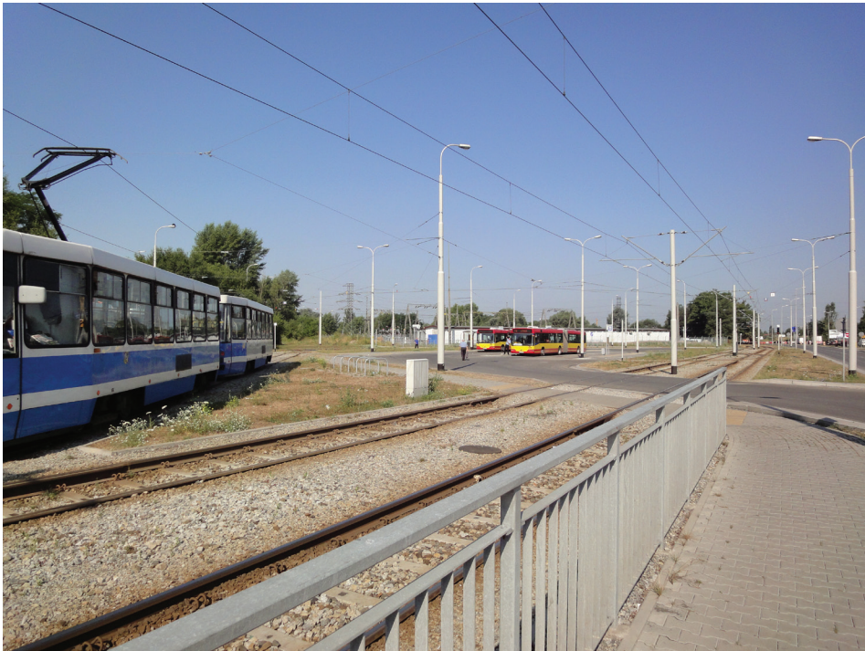
Fot. 1. Terminal przesiadkowy Pilczyce
