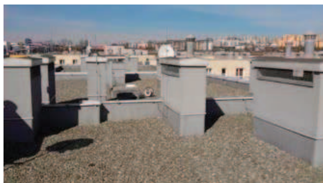
Rys. 1. Widok połaci dachowej
