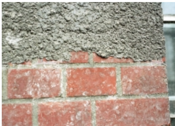
Widoczny fragment muru po usunięciu warstw cementowych nową metodą
