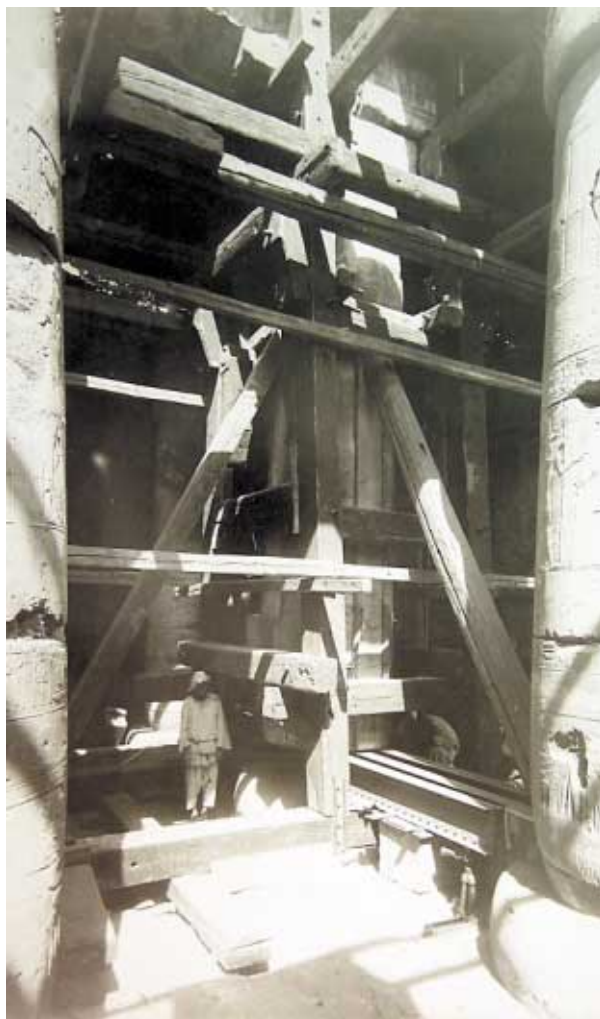
Rys. 17. Archiwalne zdjęcie z rekonstrukcji świątyni Setiego w Abydos
