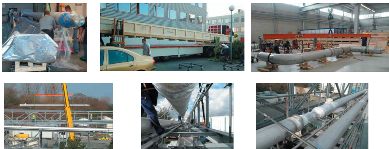
Rys. 5. Transport i montaż segmentów rurociągu
