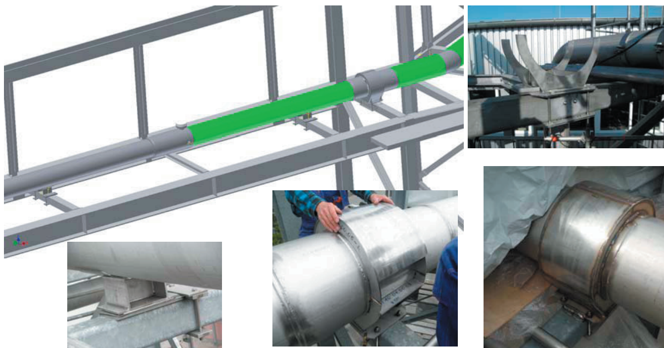
Rys. 4. Podpory rurociągu na moście – model 3D i obiekty rzeczywiste na montażu
