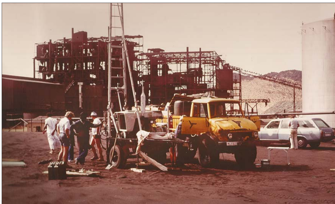
Ryc. 6. Mauretania. Rozpoczęcie wierceń (czerwiec 1981 r.) na hałdzie odpadów poflotacyjnych kopalni miedzi Akjout, w łańcuchu Mauretaniidów. Z tyłu widoczna zamknięta w 1975 r. instalacji odzysku Cu z rud tlenkowych. Czarny piasek to odpad poflotacyjny. Na zdjęciu po lewej (w krótkich spodniach) Ryszard Strzelecki, obok wiertacz Maur o nazwisku No, obok niego w białej czapce dr inż. Krzysztof Klimczyk z Wydz. Wiertnictwa AGH. Widoczna wiertnica polska konstrukcja UWSP 100, prod. ZM Oświęcim. Z tyłu przy Peugeotie 504 dr Andrzej Ostromecki Fig. 6. Mauritania. The beginning of drillings (June 1981) on the flotation waste dump of the Akjout copper mine in the Mauritanian chain. In the background, the plant of Cu recovery from oxide ores, closed in 1975. The black sand is the flotation waste. In the photo on the left: Ryszard Strzelecki (in short pants), next to him: Maur driller named No, next to him in a white cap: Dr Eng. Krzysztof Klimczyk from the Drilling Faculty of Academy of Mining and Metallurgy. A drilling rig UWSP 100 of Polish construction, manufactured by ZM Oświęcim, is visible. At the back, at a Peugeot 504: Dr Andrzej Ostromecki. From the collection of R. Strzelecki.
