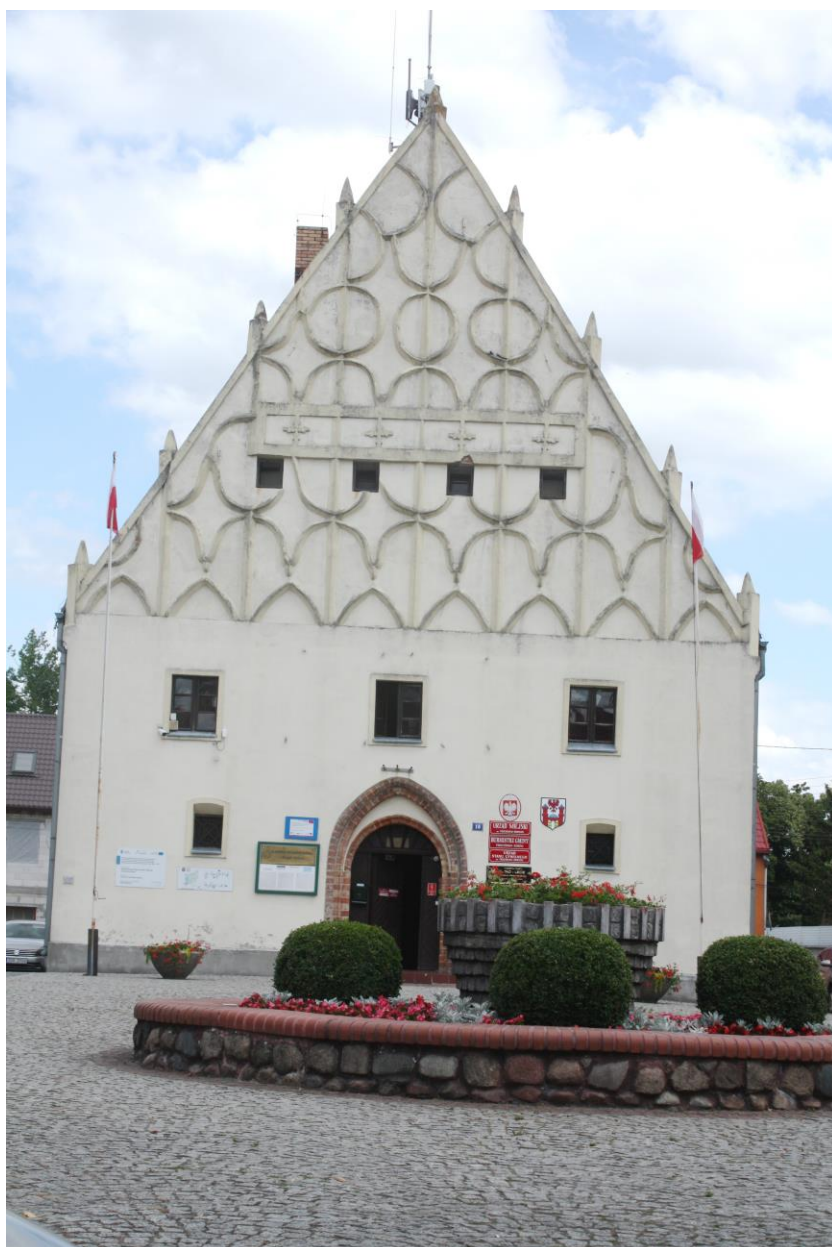
Fig. 3. Town hall in Trzcińsko-Zdrój – décor of the western gable wall; photo by Maciej Płotkowiak
