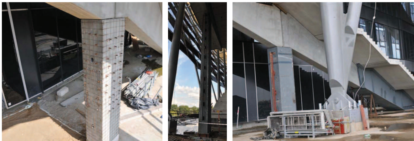
Rys. 11. Stalowe wzmocnienia schodów w trakcie realizacji (zdjęcia autorów)
